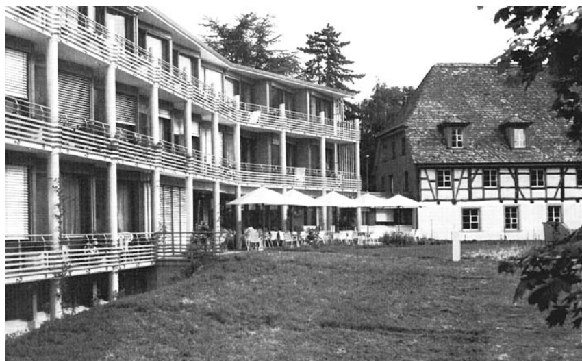
Mit der Sanierung des alten «Asyls» (auf unserm Bild rechts) erfolgte die Verschmelzung von Altbau und Neubau des städtischen Altersheims Steig.
